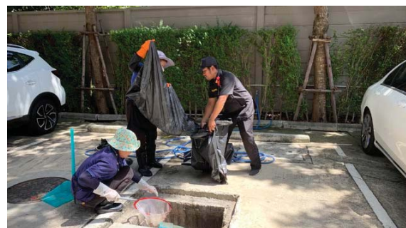
การตัดไขมันออกจากบ่อบำบัดน้ำเสีย
